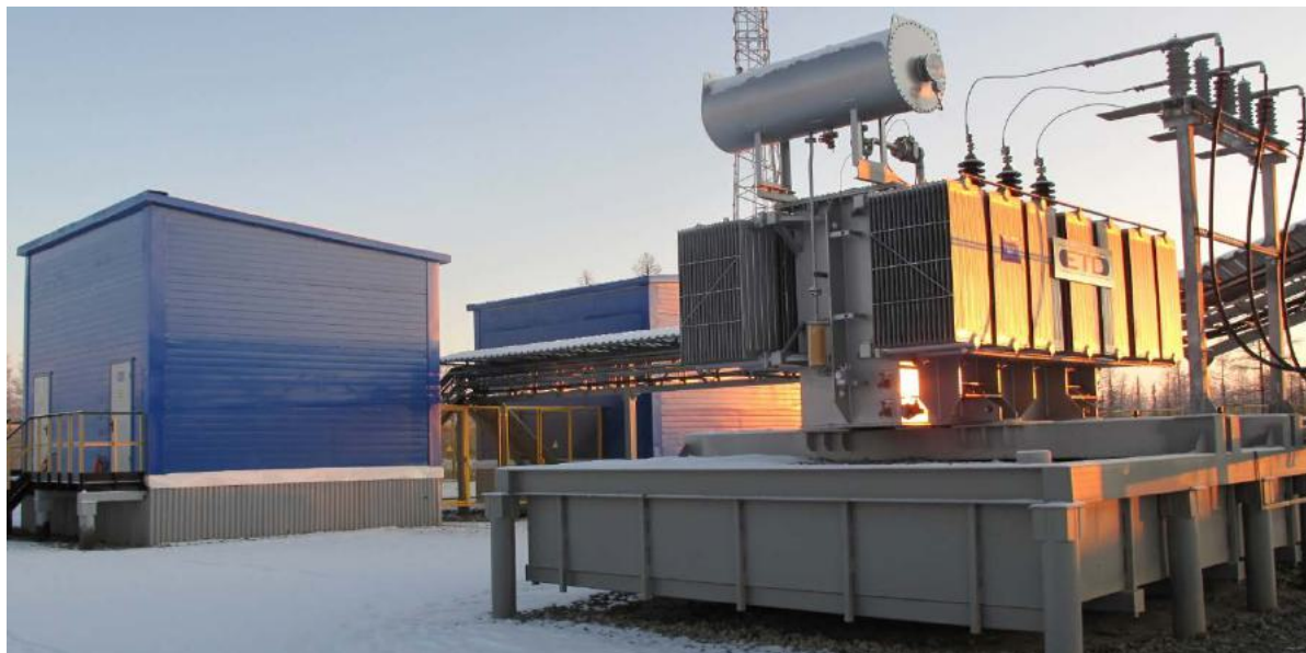
Источник реактивной мощности на базе УШР типа РТМУ-10000/35-УХЛ-1 на ПС 35 кВ «Ванкор», 2011 г.
