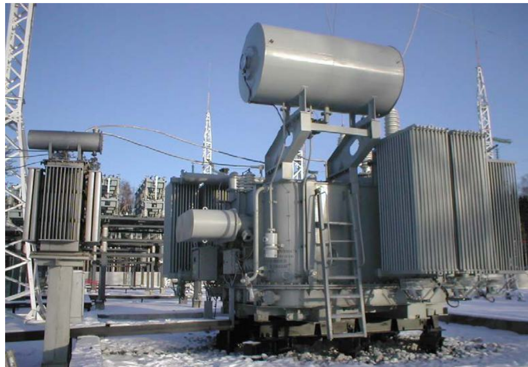
Управляемый реактор РТУ-25000/110 на п/с 110/35/6 кВ «Двуреченская»
